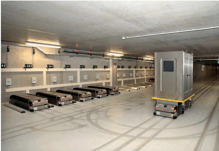
Abb. 31: Batterieladestation im Untergeschoss
