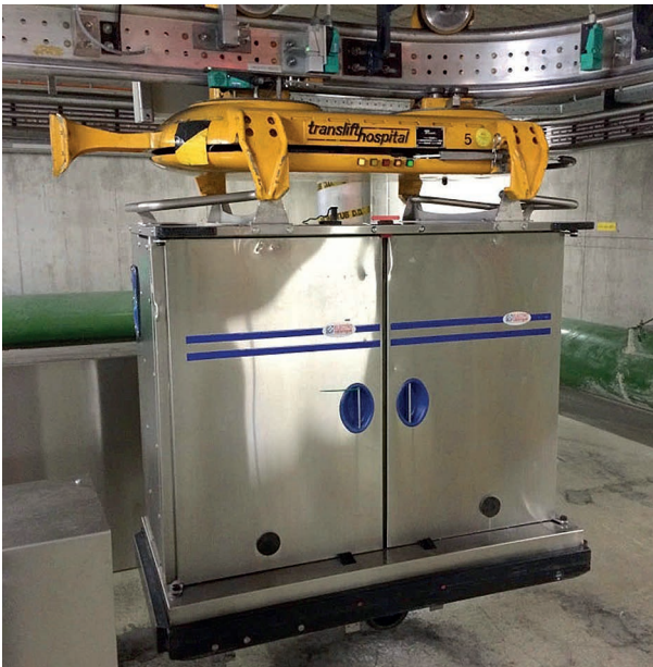
Abb. 3: Einschienen-Elektrohängebahn (EHB) als AWT-Anlage von 1985 im Klinikum Reutlingen
